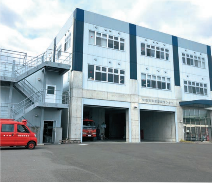
▲安芸市消防防災センター 高機能消防司令システム・消防救急デジタル無線システムを有し、災害時には救助や支援派遣を円滑に行えるよう海岸部の監視カメラ・潮位計システムを設置。地域防災の拠点となる。
