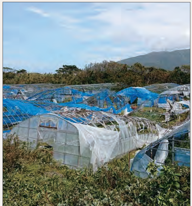
▲ビニールが破け骨組みも破損してしまったハウス ハウス内の作物にも被害
