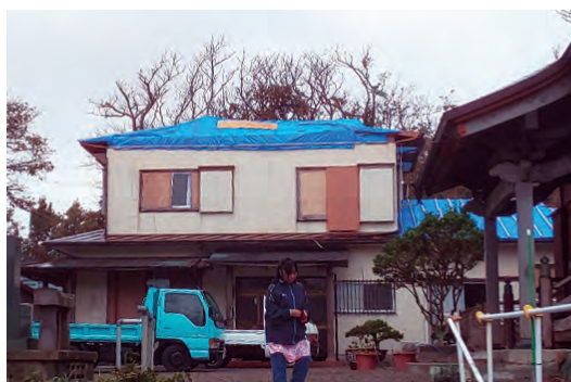
▲台風15号で被災した民家。村内の民家は被害の大小はあるが、ほとんどの民家が被災した。
