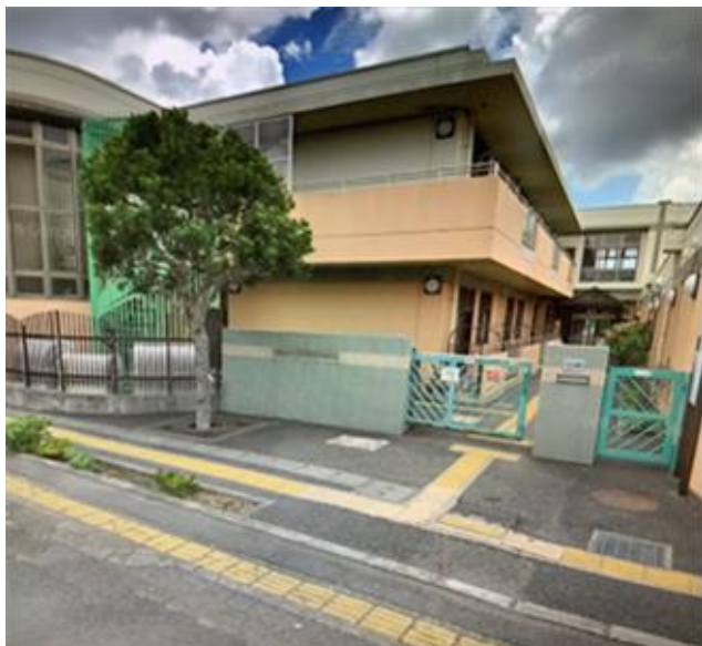
▲八王子盲学校の寄宿舎。島しょ地区から特別支援高等部に進学する生徒の寄宿先になる
