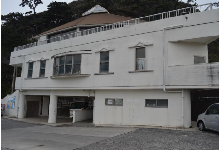
▲式根島野伏漁港船客待合所および同施設内トイレ
