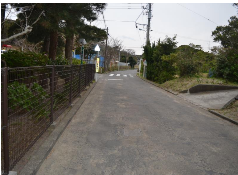
▲式根島小学校・保育園前の道路補修工事後
