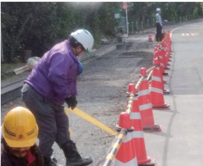
▲着々と進む式根島公共下水道工事の現場
