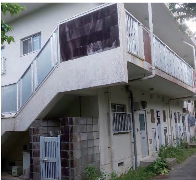
▲式根島の村営住宅2棟8戸
