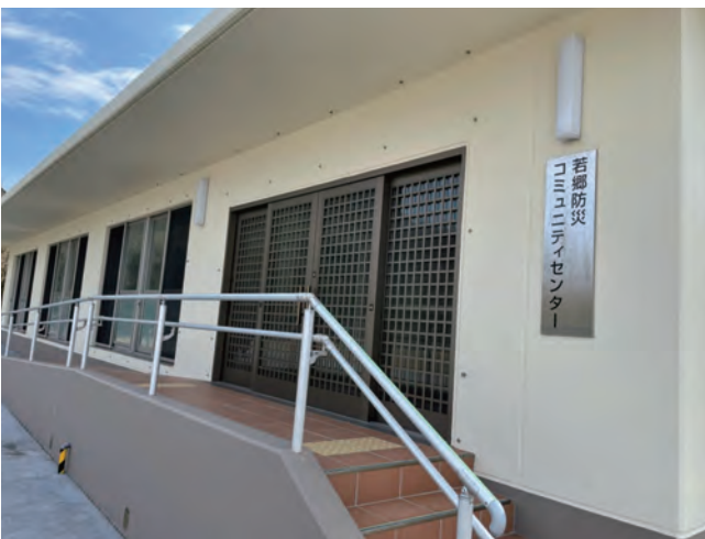
▲2021年に完成した若郷防災コミュニティセンター
