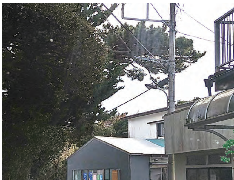
▲松食い虫の拡散防止と自然災害からライフラインを守るために!
