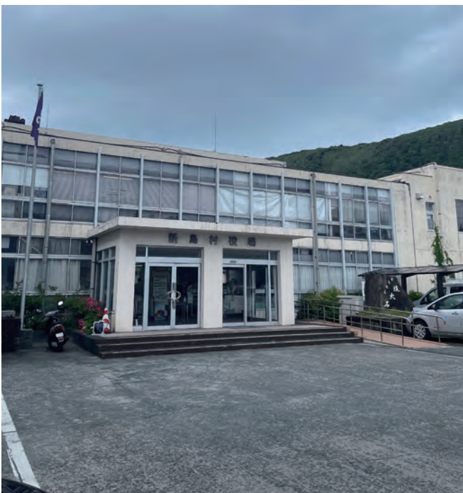
▲老朽化の著しい新島村役場。一刻も早い新庁舎の建設を！！
