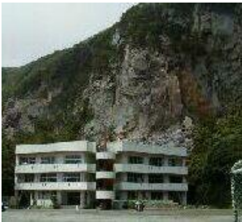
裏山が崩落した
