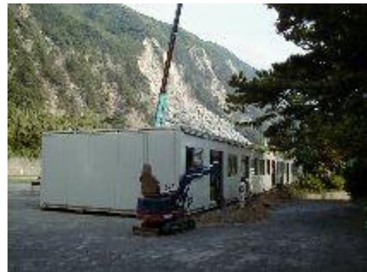
急ピッチで進められた仮設校舎
